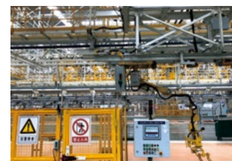
湖北荆门装备制造产业园现场
